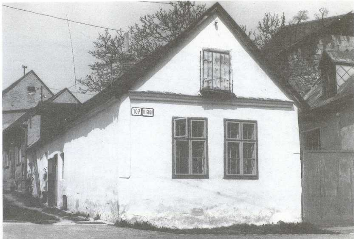
Zástavba dvora vinohradníckeho domu na Kirovovej ul. č. 107, datovaného do druhej polovice 18. storočia. Foto J. Podoba 1987
