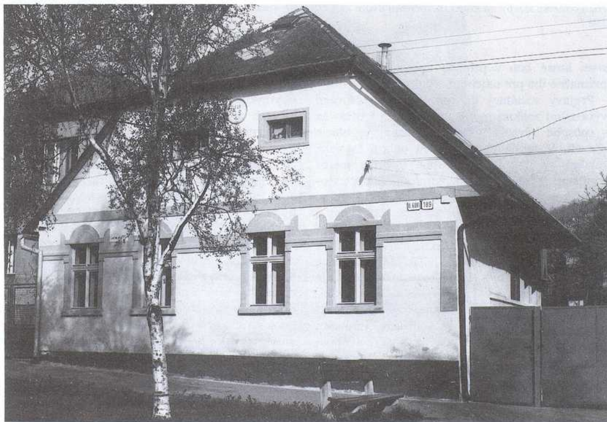
Kirovova ul. č. 189. Štvorosový dvojdielny vinohradnícky dom, prestavaný r. 1919. Foto J. Podoba 1987
