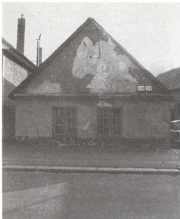
Kirovova ul. č. 120. Priečelie typického vinohradníckeho domu z druhej polovice 19. storočia. Foto J. Podoba 1987
